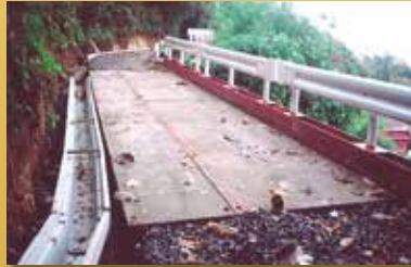
覆工板設置完了
