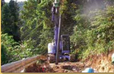
材料吊りこみ
