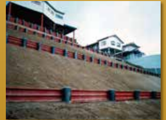
安定化工事完了
