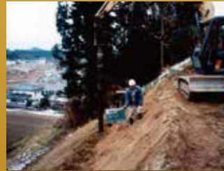
バックホウによる施工
