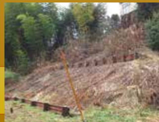
東日本大震災後 杭の変位は認められない。
