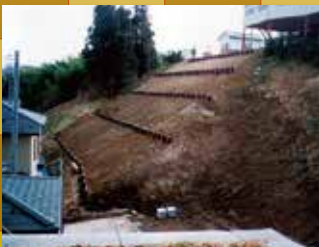
安定化工事完了
