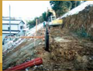
バックホウによる施工
