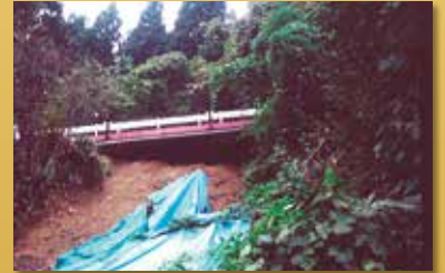
崩落道路の仮復旧状況
