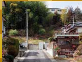
東日本大震災後 法面の崩落はない。
