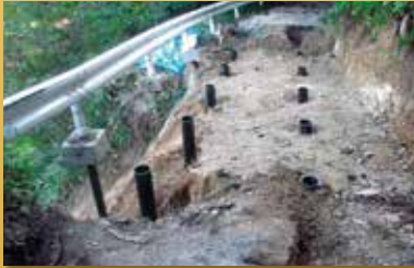
bDパイル施工完了
